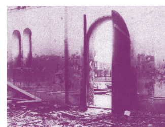
Vstupní dveře do obřadní síně na židovském hřbitově U Křížku před demolicí v roce 1956
