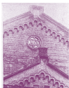
Štít obřadního domu na židovském hřbitově u U Křížku v Pekárenské ulici před demolicí v roce 1956
